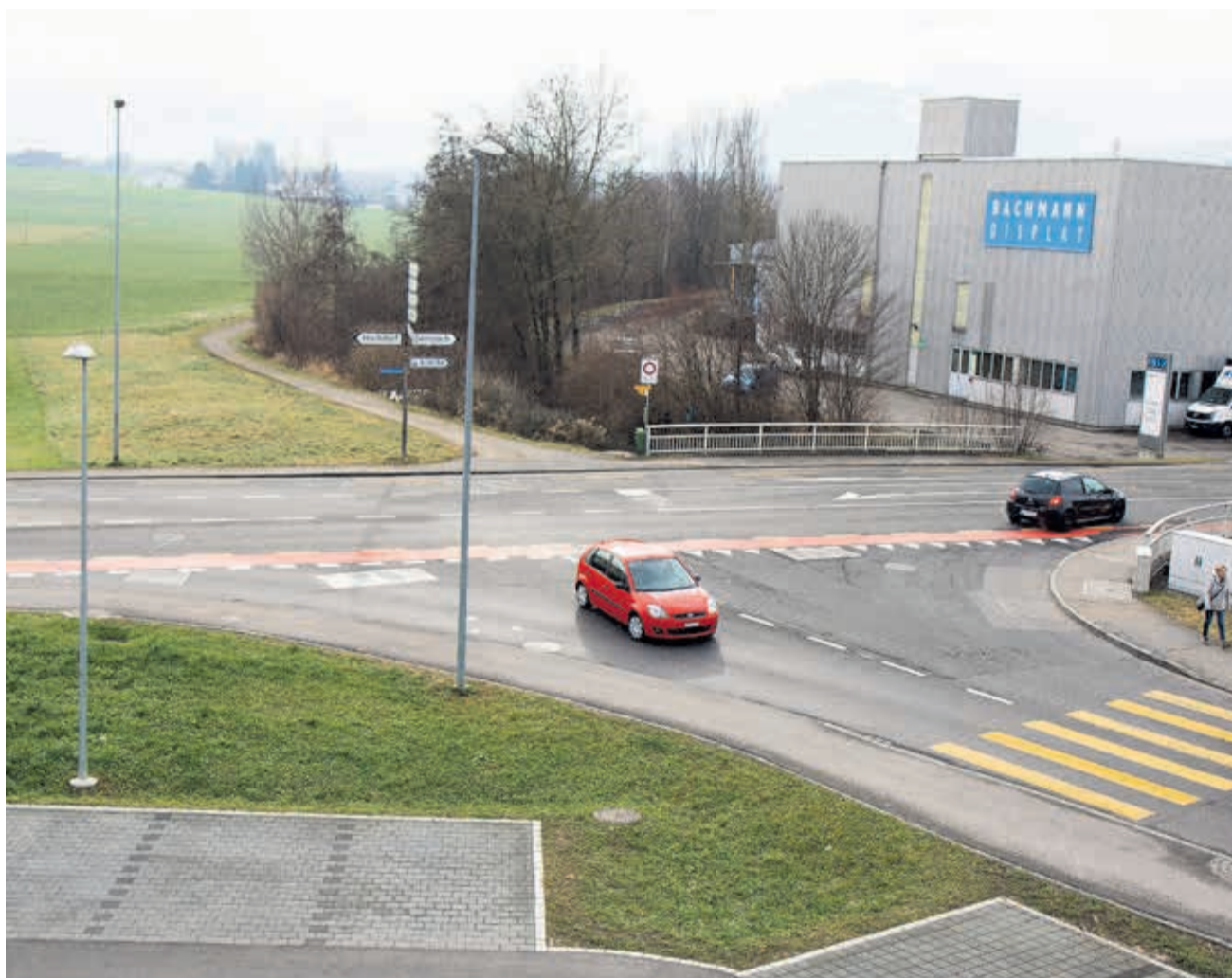
Die Südumfahrung würde an dieser Stelle entlang der Ron in die Industriestrasse einmünden. Foto Claudio Brentini
